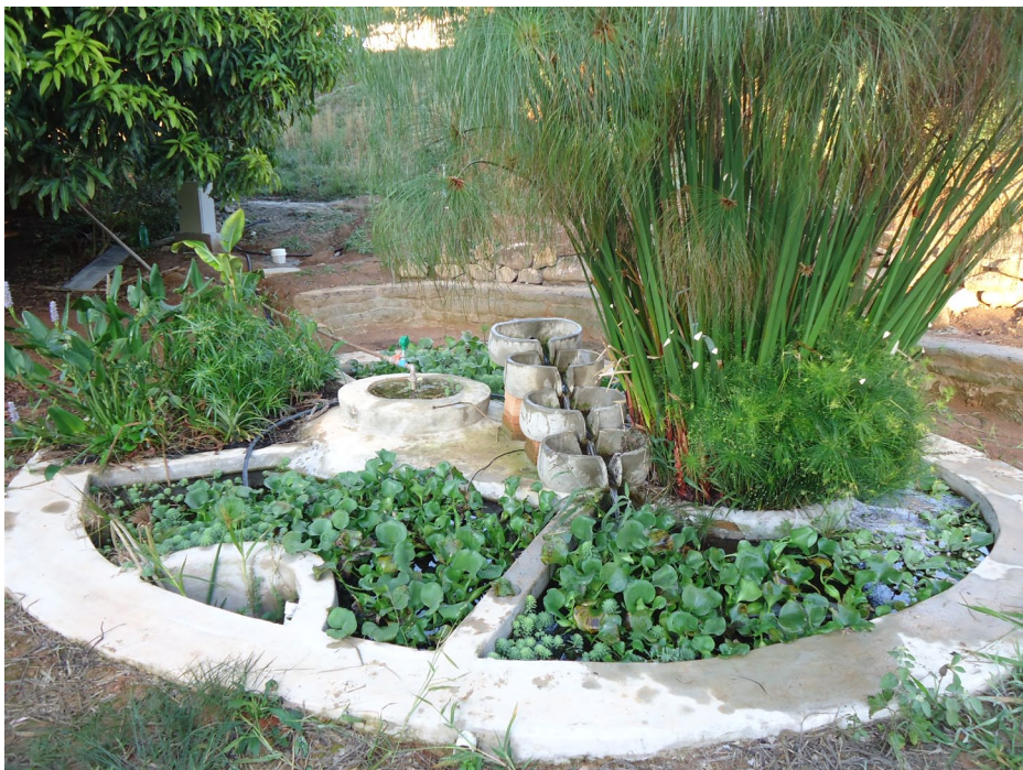
Plantas emergentes e flutuantes em Zona de Raízes de fluxo horizontal, instalação residencial em Pedra Bela/SP (emergentes nas extremidades direita e esquerda, e aguapés no primeiro plano e ao fundo). Foto: Guilherme Castagna.
