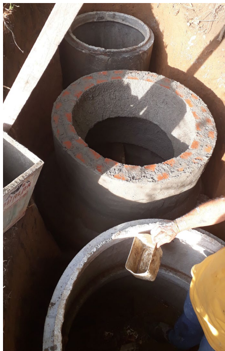
Chapisco sobre gargalo (à esq.), e reboco sobre gargalo (à dir.). Verava, Ibiúna/SP. Foto: Paola Samora.
