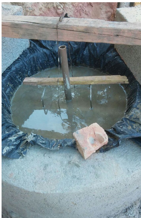
Base sem concreto e sem ferragem (à esq.), e tampa concretada (à dir.). Verava, Ibiúna/SP. Foto: Paola Samora.
