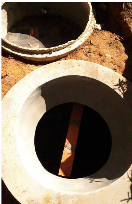
Instalação da parede divisória com tubos de entrada e de saída ao fundo (à esq.), e vista superior da parede divisória (à dir.). Verava, Ibiúna/SP. Foto: Paola Samora.
