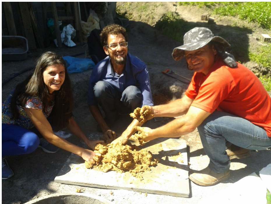
Paola Samora, Guilherme Castagna e Rosemiro Oliveira preparando a massa de vedação para ser aplicada na tampa e entrada do biodigestor. Verava, Ibiúna/SP. Foto: Acervo IPESA.
