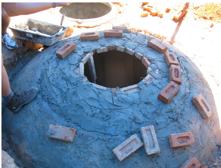
Vista ampliada da construção da cúpula em tijolos maciços (por Valmir Fachini). Pedra Bela/SP. Fotos: Guilherme Castagna.
