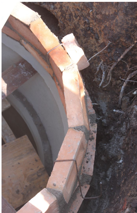
Guia para assentamento dos tijolos da cúpula (à esq.), e detalhe do contrapeso para assentamento dos tijolos da cúpula (à dir.). Verava, Ibiúna/SP. Foto: Paola Samora.
