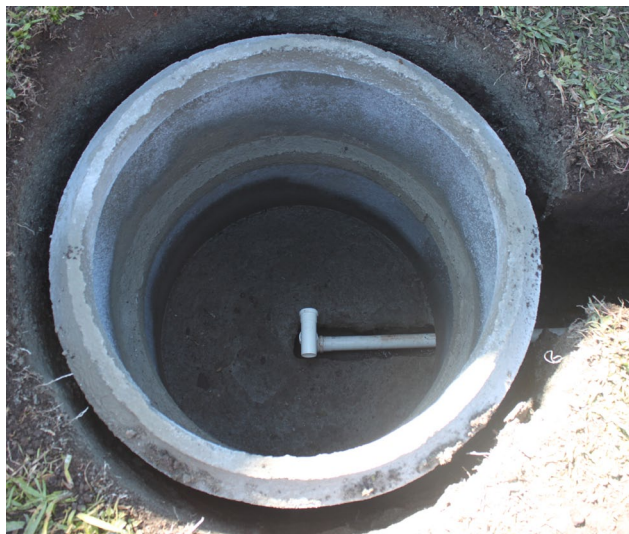
Instalação da tubulação de fundo. Verava, Ibiúna/SP. Foto: Paola Samora.
