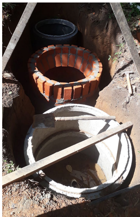
Miro assentando a fiada final interna (à esq.), e fiada final interna concluída (à dir.). Verava, Ibiúna/SP. Foto: Paola Samora.
