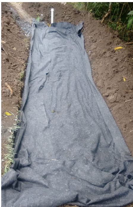
Aplicação de manta bidim sobre leito de pedras (antes da cobertura com solo). Verava, Ibiúna/SP. Foto: Rosemiro P. Oliveira.
