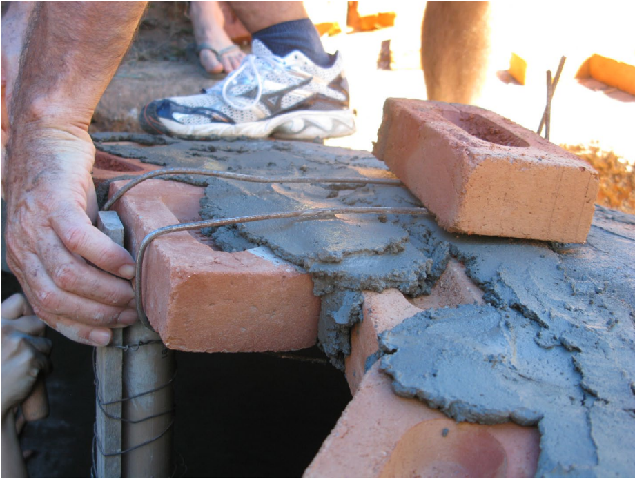
Passo-a-passo do uso do contrapeso para construção de cúpula em tijolos maciços (por Valmir Fachini). Pedra Bela/SP. Fotos: Guilherme Castagna.
