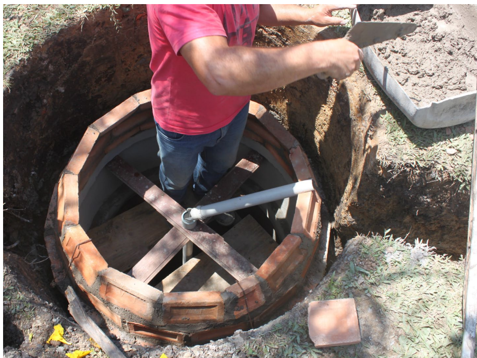
Vista para a guia e tijolos da cúpula. Verava, Ibiúna/SP. Foto: Paola Samora.
