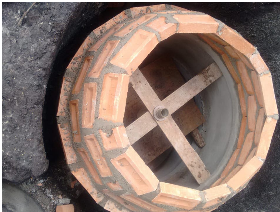
Vista para a guia e cúpula concluída. Verava, Ibiúna/SP. Foto: Paola Samora.
