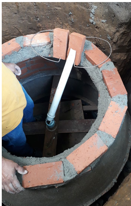
Miro iniciando o assentamento dos tijolos do gargalo (à esq.) e continuação do assentamento dos tijolos do gargalo (à dir.). Verava, Ibiúna/SP. Foto: Paola Samora.
