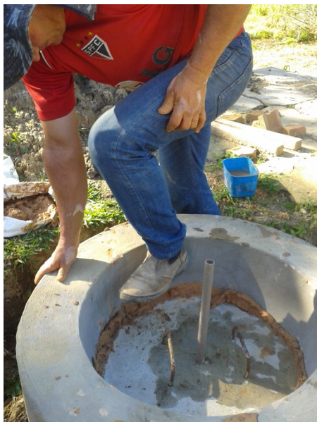
Instalação da tampa sobre o gargalo do biodigestor (à esq.), e assentamento final da tampa, sobre o gargalo, com os pés (à dir.). Verava, Ibiúna/SP. Foto: Paola Samora.
