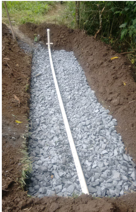
Aplicação de brita e assentamento de tubo de PVC perfurado (tubo dreno) (à esq.), e detalhe do tubo de PVC perfurado (à dir.). Verava, Ibiúna/SP. Foto: Rosemiro P. Oliveira.
