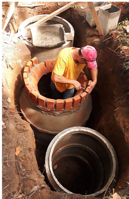
Miro fazendo o assentamento da fiada final externa. Verava, Ibiúna/SP. Foto: Paola Samora.
