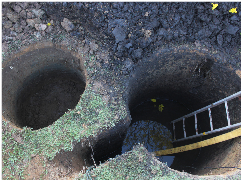
Escavação pronta para a descida dos anéis de concreto. Verava, Ibiúna/SP. Foto: Paola Samora.
