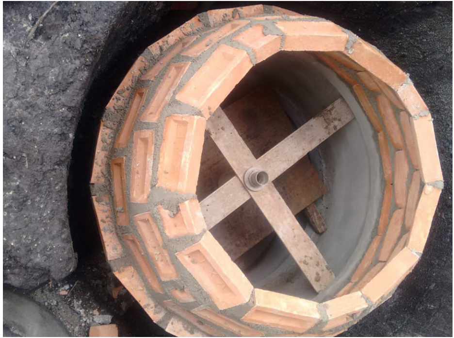
Vista para a guia e cúpula concluída. Verava, Ibiúna/SP. Foto: Paola Samora.
