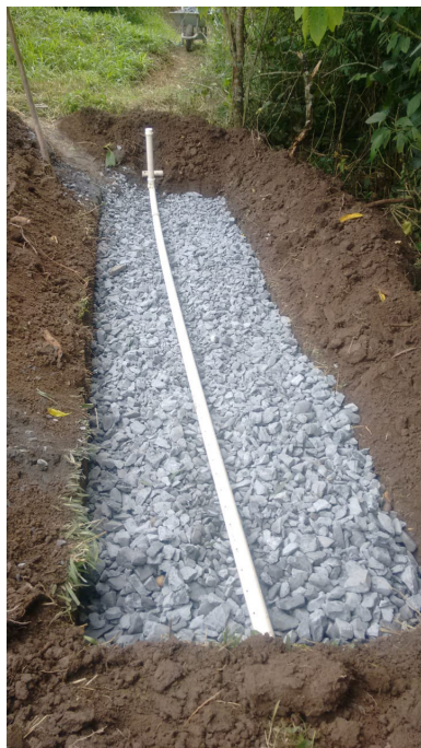
Processo de construção da vala de infiltração. Verava, Ibiúna/SP. Foto: Rosemiro P. Oliveira.
