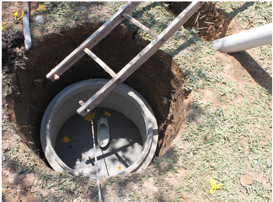
Chegada da tubulação do biodigestor na base da caixa de compensação. Verava, Ibiúna/SP. Foto: Paola Samora.
