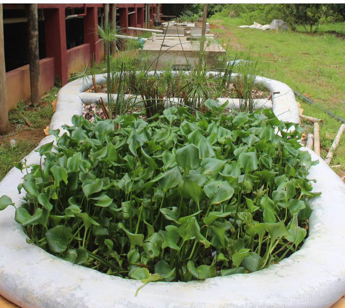
Aguapés na Zona de Raízes implantada no Banana Bamboo Ecolodge, Ubatuba/SP. Foto: Banana Bamboo.
