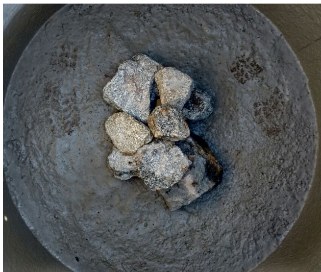
Proteção da tubulação de fundo com pedras graúdas. Verava, Ibiúna/SP. Foto: Paola Samora.
