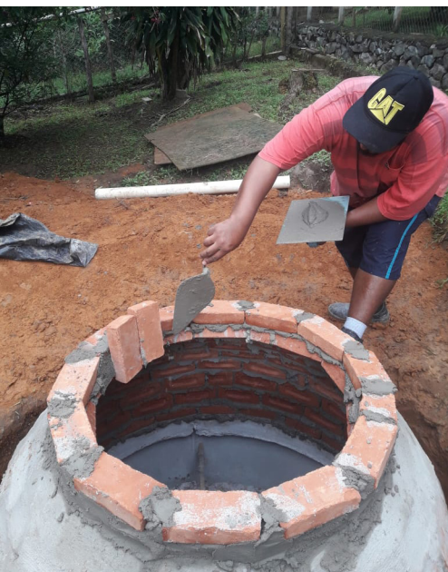
Elias Moraes construindo a cúpula do Biodigestor. Projeto Escola Waldorf Guayi/ Humanaterra, Embu das Artes/SP. Foto: Bruno Helvécio.
