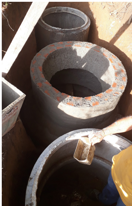
Chapisco sobre gargalo (à esq.), e reboco sobre gargalo (à dir.). Verava, Ibiúna/SP. Foto: Paola Samora.
