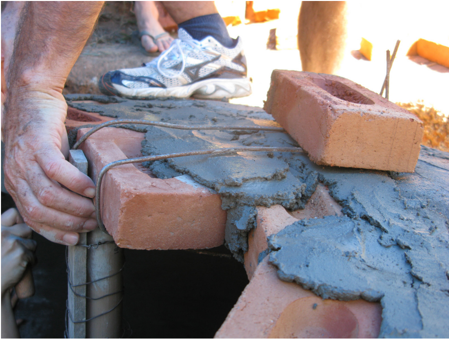
Passo-a-passo do uso do contrapeso para construção de cupula em tijolos maciços (por Valmir Fachini). Pedra Bela/SP. Fotos: Guilherme Castagna.
