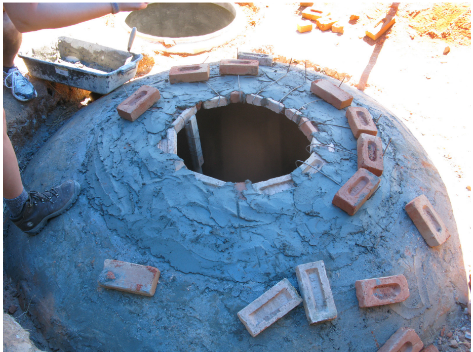
Vista ampliada da construção da cúpula em tijolos maciços (por Valmir Fachini). Pedra Bela/SP. Fotos: Guilherme Castagna.
