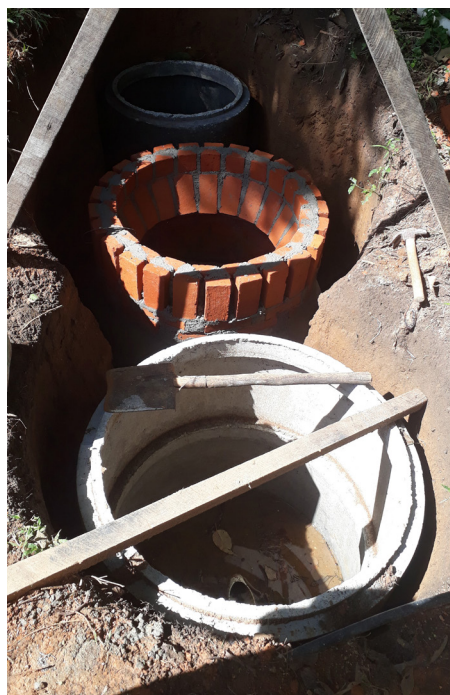
Miro assentando a fiada final interna (à esq.), e fiada final interna concluída (à dir.). Verava, Ibiúna/SP. Foto: Paola Samora.
