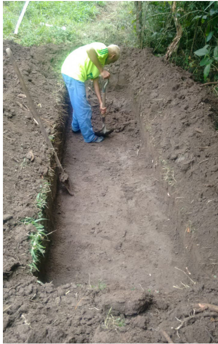
Escavação da vala de infiltração (à esq.), e escavação concluída (à dir.). Verava, Ibiúna/SP. Foto: Rosemiro P. Oliveira.
